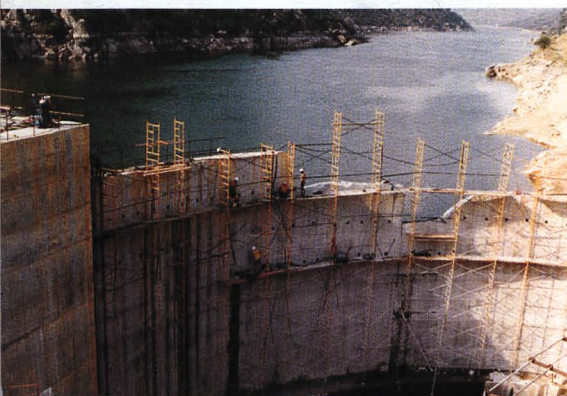
Demolición muro ataguía en Saucelle (Salamanca). Técnica: Taladros de 200 mm. y gatos hidráulicos.
