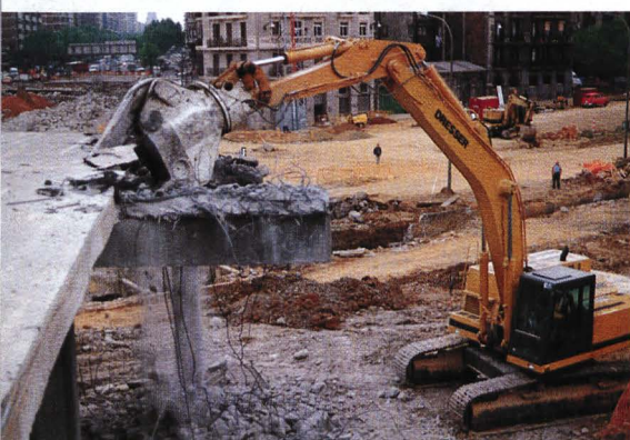
Demolición de hormigón. Técnica: Pinza demoledora.
