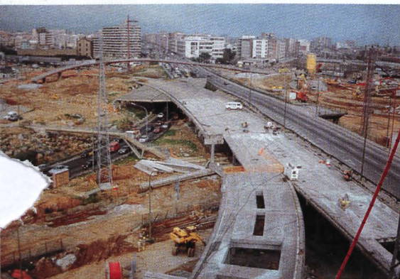
Plaza de las Glorias (Barcelona). Técnica: Disco de diamante, gatos hidráulicos y pinza demoledora.
